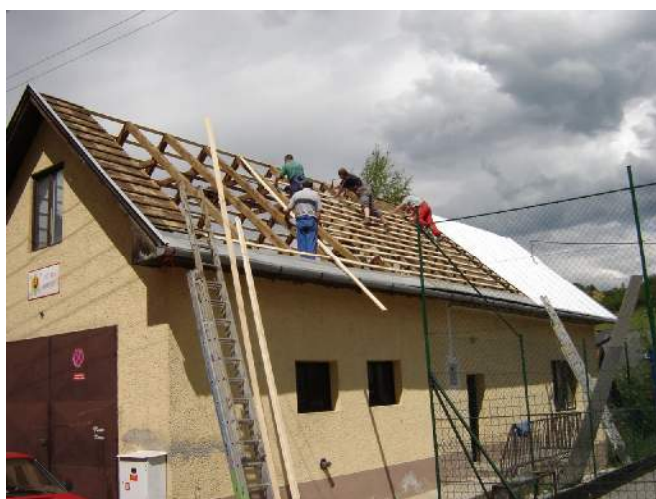
Výmena krytiny na hasičskej zbrojnici
