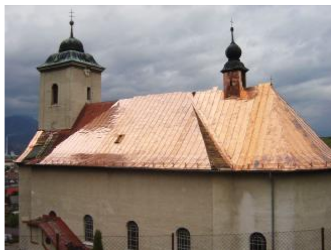
Montáž medenej krytiny na farskom kostole
