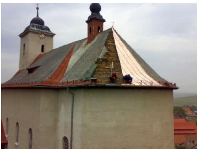
Montáž medenej krytiny na farskom kostole
